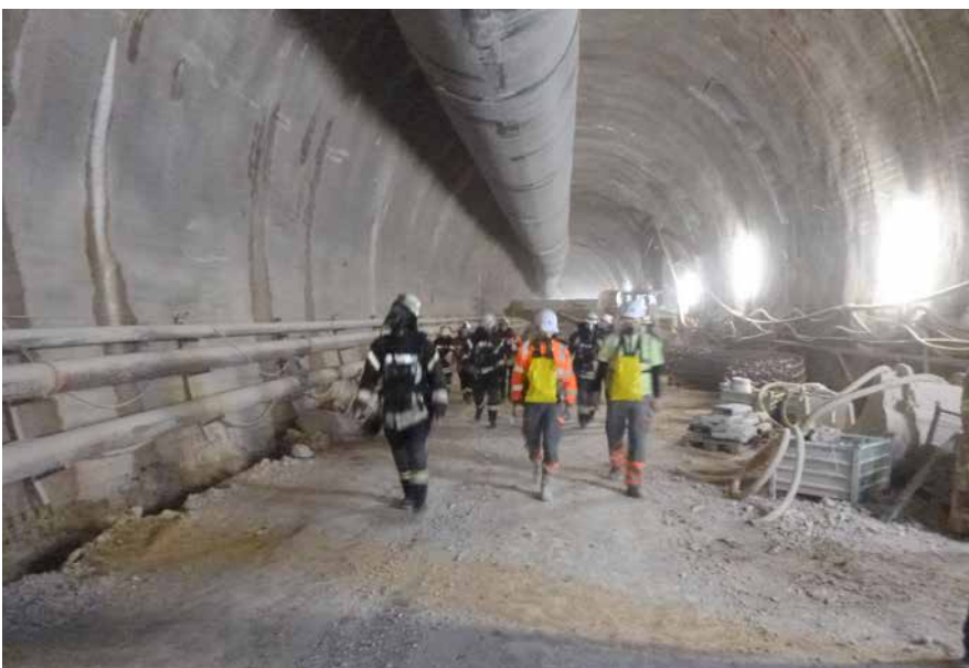
Die Rettungseinheit mit Tunnelbauarbeitern auf dem Weg ins Freie; im Hintergrund sind Rettungscontainer erkennbar
